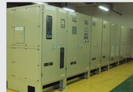
[그림 2] 대전-시청변전소 에너지 저장시스템
