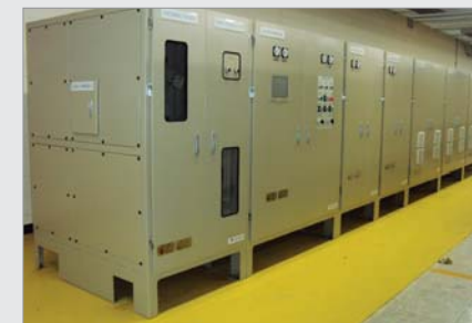
[그림 3] 대전-감전변전소 에너지 저장시스템
